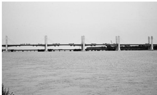
东明黄河大桥
