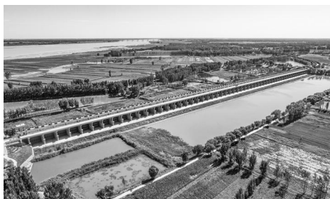
渠村黄河分洪闸
